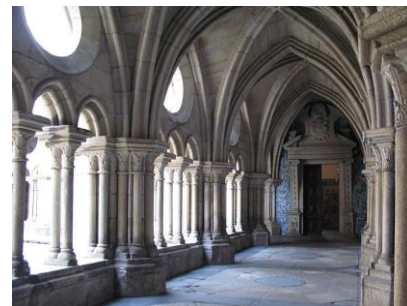
Křížová chodba, 13. st.
